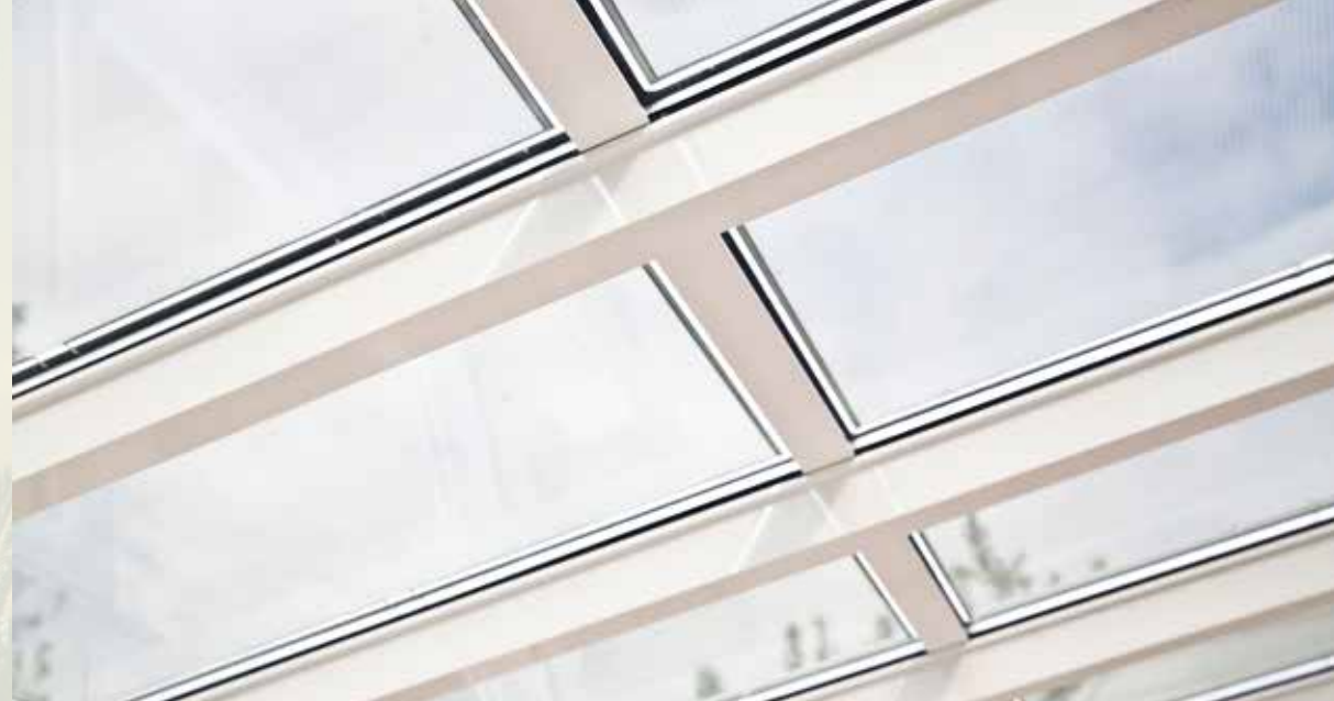
▲ Dacheindeckung mit semitransparenten PV-Modulen und innenliegenden Statikprofilen
